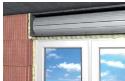
Швы в месте крепления оконных жалюзи
