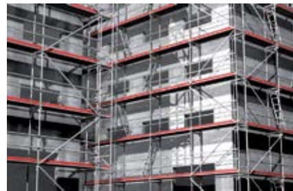
Фасадные строительные леса
