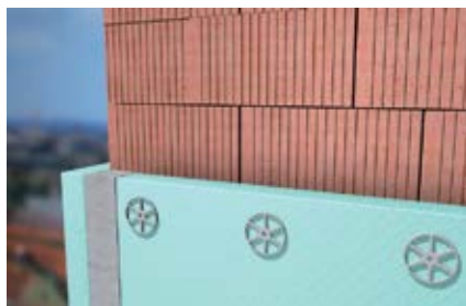
Заполнение полостей в изоляции
