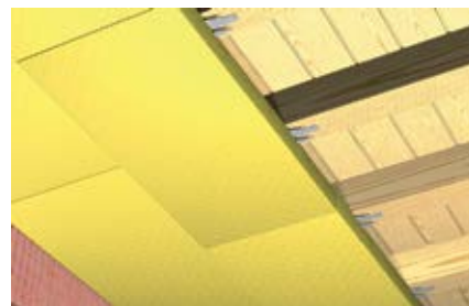
Прочные на сжатие термоизоляционные панели при креплении к потолку
