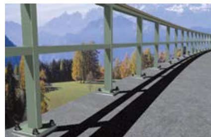
Перильные ограждения мостов
