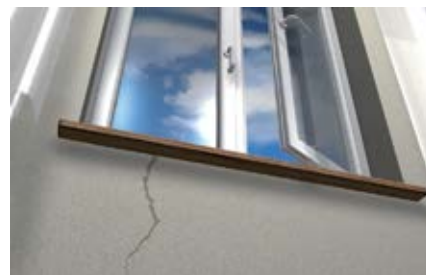
Заделка внутренних трещин в кирпичной кладке
