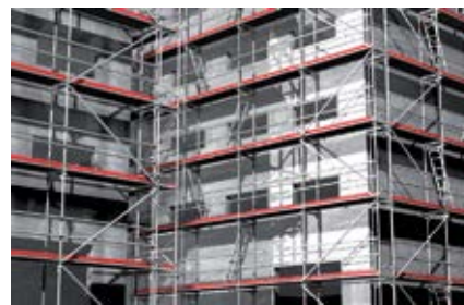
Фасадные строительные леса
